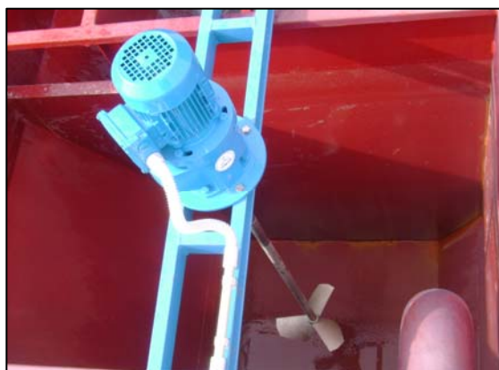
Fig: Agitador cámara coagulación
